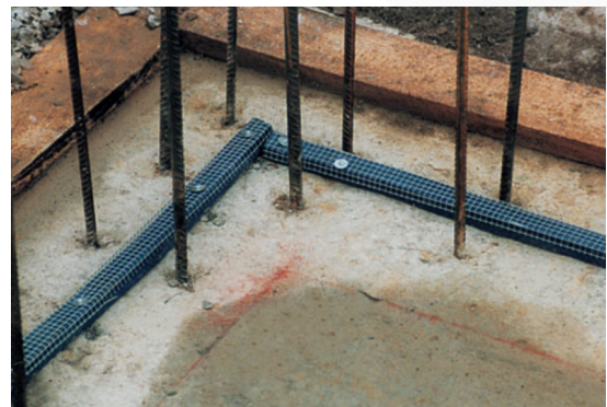
Leggen met bevestigingsnetten en nagels
